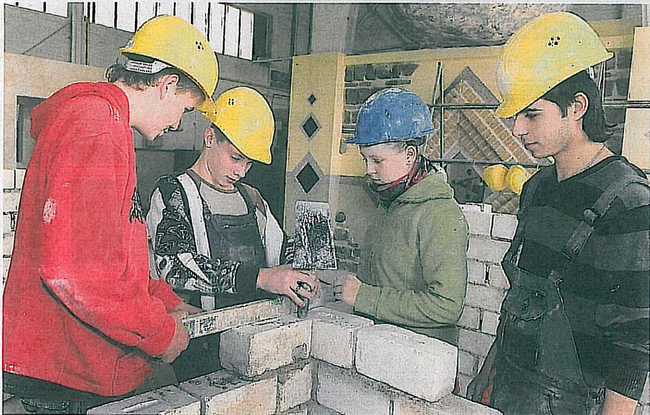
Stein für Stein wächst die Mauer, an der (von links) Mike (15), Valerie (15), Sarah (16) und Selim (15) gemeinsam arbeiten.
